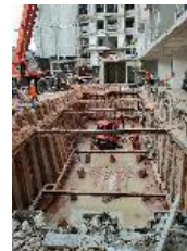
รูปที่ 2.24 การติดตั้ง Sheet Pile
